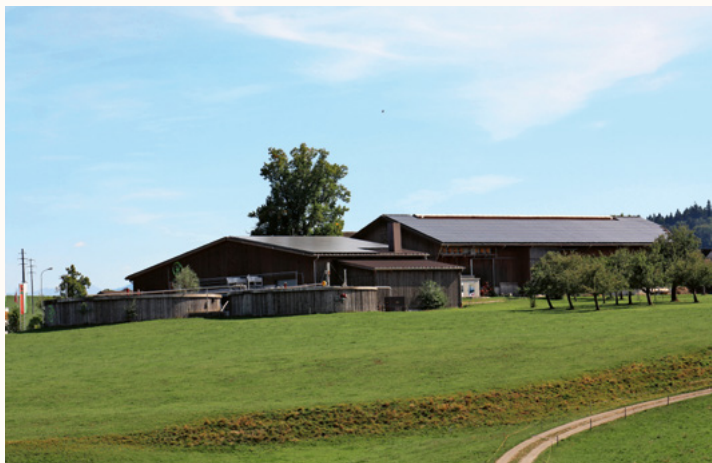
Der Landwirtschaftsbetrieb mit Biogasanlage und Photovoltaik.
