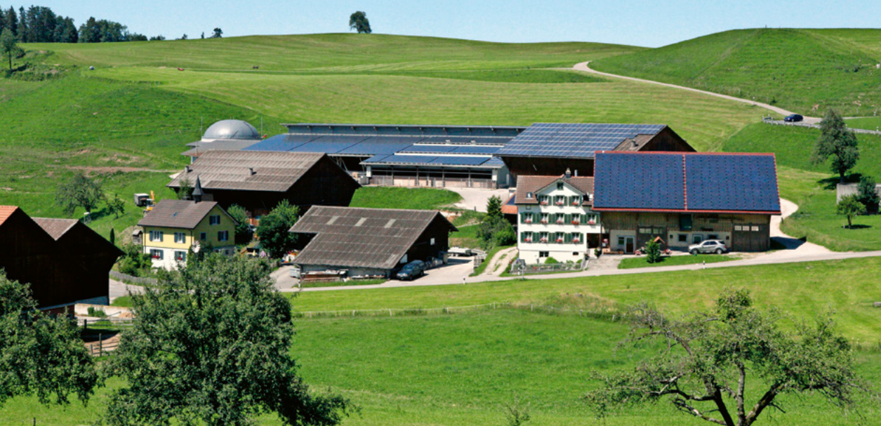
Innovativer, auf Energie ausgerichteter landwirtschaftlicher Betrieb in der Gemeinde Fischingen. Bild: Archiv/meg.
